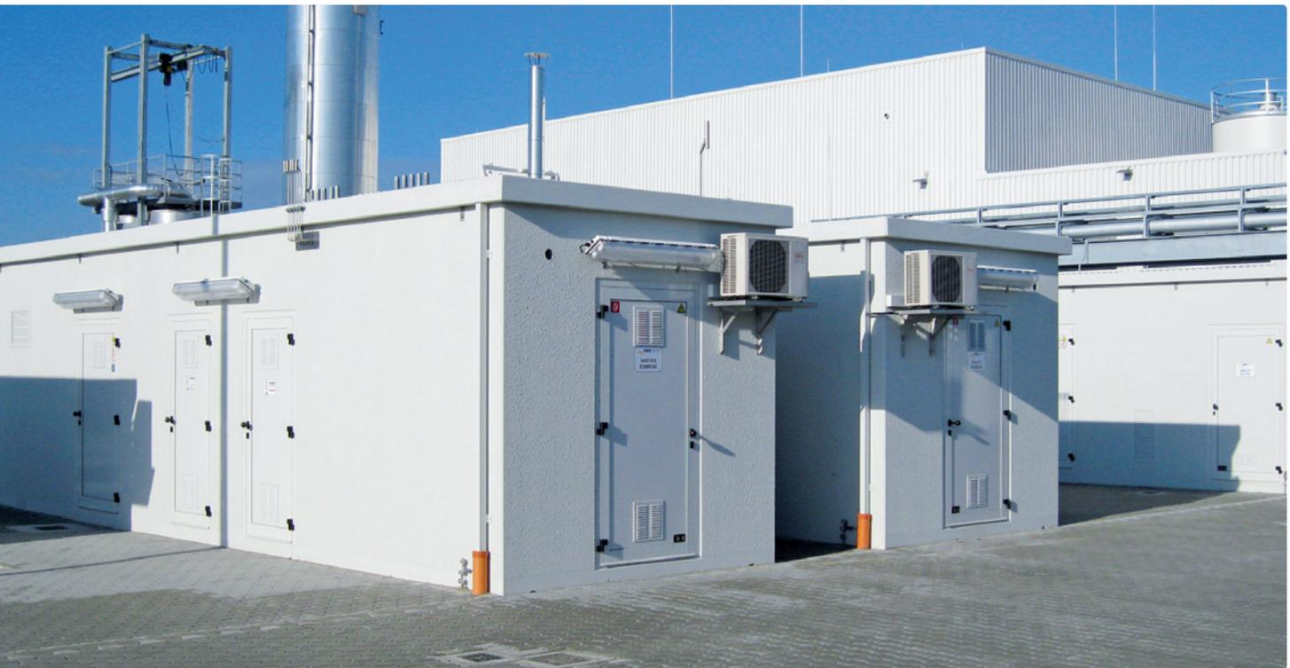
Gasstationen kommen in der Erdgasversorgung zum Einsatz. Sicherheit steht in diesem sensiblen Bereich an erster Stelle: Die bauliche Auslegung erfolgt gemäß DVGW-Arbeitsblatt G 491. GRÄPER-Stationen sind so konstruiert, dass die gasdichte Trennung der Räume untereinander sichergestellt
