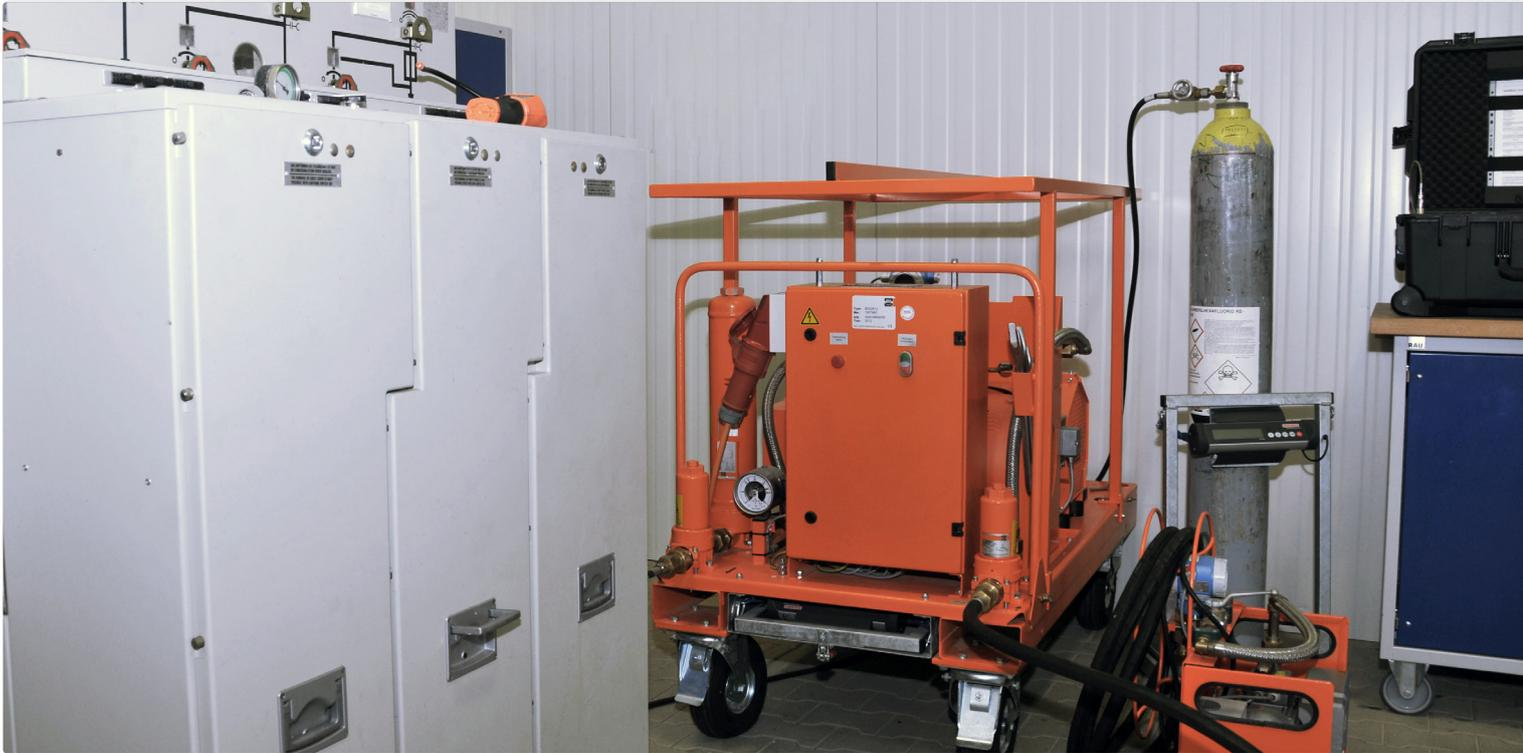
SF<sub>6</sub>-gasisolierte Schaltanlagen unterliegen einem Alterungsprozess und haben eine endliche Lebensdauer. Der Gesetzgeber schreibt nicht nur eine regelmäßige Wartung der Anlagen, sondern auch eine fachgerechte Entsorgung des Isoliergases am Lebensende der Schaltanlage vor. Eine Aufgabe, die in die Hände von Profis gehört und nur von zertifiziertem und sachkundigem Fachpersonal durchgeführt werden darf.
